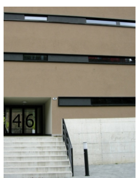
④ Wohnüberbauung Reussinsel 42 - 46 System K5 Oberfläche: Vollabrieb
