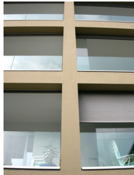
② Mehrfamilienhaus Höhenweg 8 System K5 Oberfläche: Quarzputz geglättet
