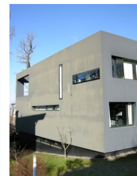
⑨ 2 Doppel EFH Dreilindenstrasse 75 System K5 Oberfläche: Feinputz gestrichen
